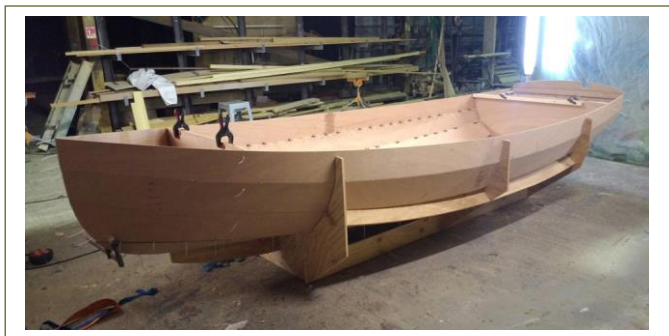
L'assemblage des clins en cousu-collé.
