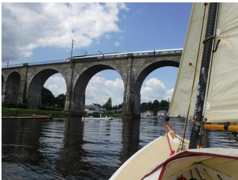
Pont SNCF à l'entrée d'Hennebont.
