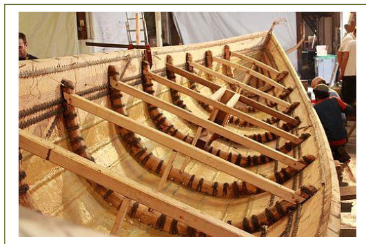
Le Gyptis en construction. On voit bien les coutures des bordés (l'enduit d'étanchéité est à base de cire et de poix de conifères) ainsi que les membrures ployées et ligaturées. Les barrots servent aussi de bancs, ce qui ne doit pas être très confortable pour la nage !
