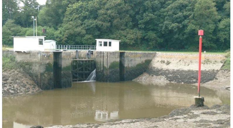
Entrée aval de l'écluse de Pontrieux à BM
