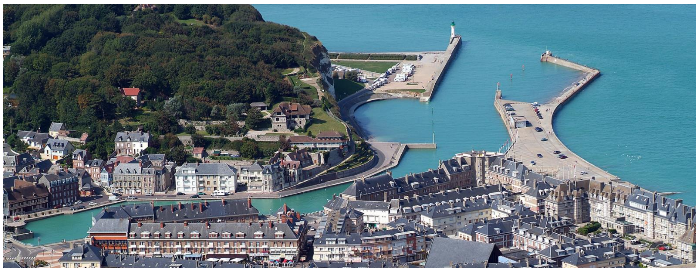
Port de St Valéry : l'avant-port par marée haute de fort coefficient.
